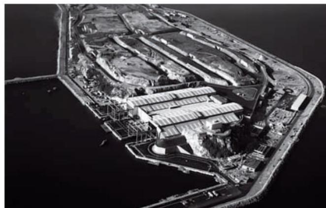
LA PRESQU'ÎLE APRÈS LES TRAVAUX.
