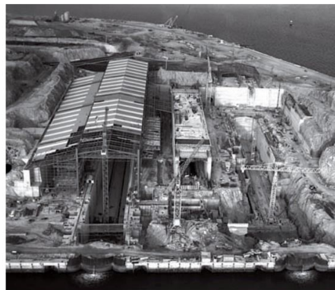
LES TRAVAUX DE CONSTRUCTION DES BASSINS.
