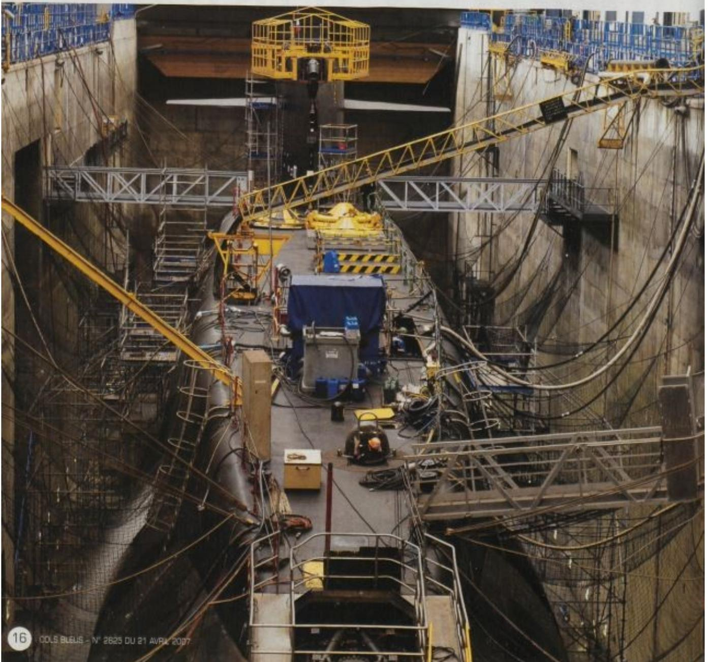
remorquée par le SNLE. Une opération délicate réalisée par une équipe de détecteurs ASM et manœuvriers. La section récupère également les antennes des sous-marins nucléaires d'attaque français ou étrangers de passage. Dès que le sous-marin touche le quai ou entre au bassin, le secteur Servitude prend le relais. Il s'agit en premier lieu de sécuriser le pont du navire en installant des filières de protection pour éviter les chutes de personnel et de procéder ensuite aux différents raccordements.
