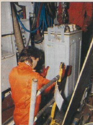
Mise en place du «faux cœur». (Photo DCN Cherbourg)
