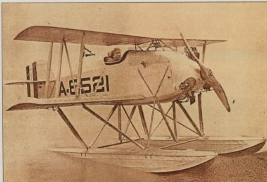
Hydravion MS-1 embarqué sur le sous-marin américain S-1. Envergure : 5,50 m - L : 5,60 m - Poids : 500kg - vitesse max : 160 km/h (D.R.)
