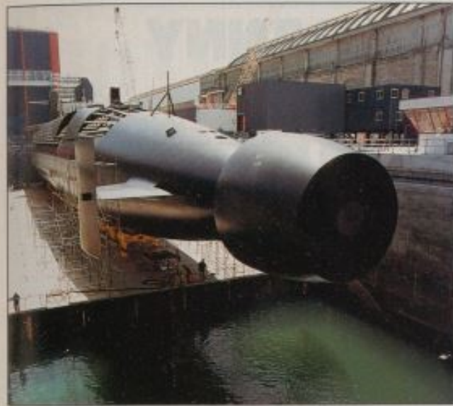
...Descente en fond de forme, juillet 1993... (photo DCN Cherbourg)
