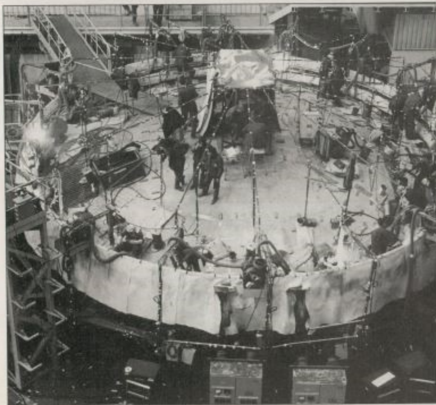
Soudage d'une cloison résistante par procédé MAG FI fourré. (photo D.R.)
