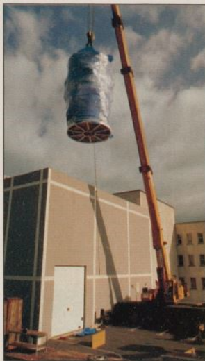
De grands moyens ont été déployés lors de la livraison du TLM au CEI/SNLE : une grue routière de 86 tonnes avec une flèche de 48 mètres. (Photo DCN Brest)
