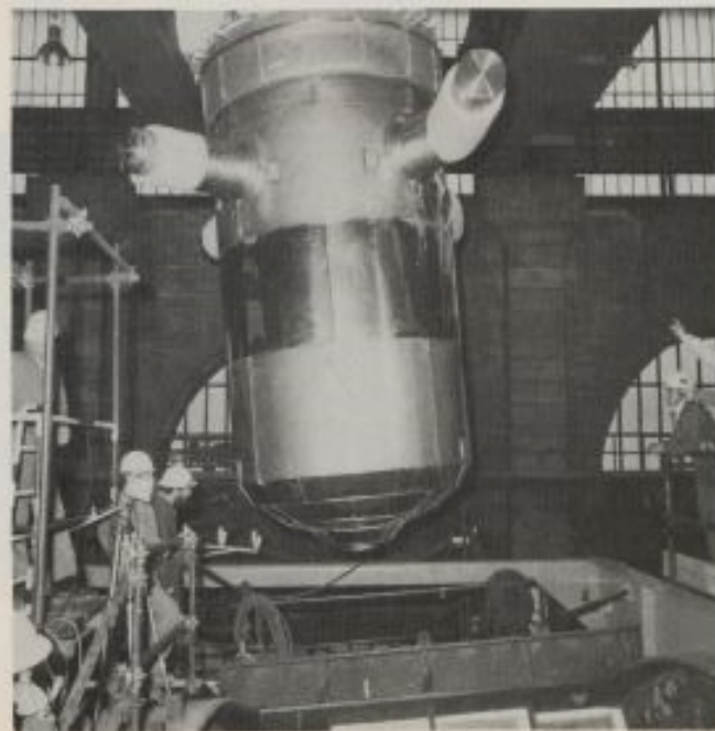
Le RNG a qualifié la chaufferie nucléaire du SNLE Le Triomphant, ici en cours d'embarquement à DCN Cherbourg (Photo DCN Cherbourg).
