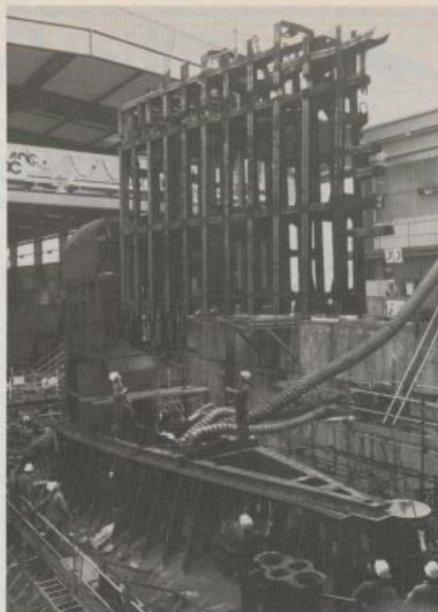
Mise en place de la partie inférieure de la charpente avant (à gauche) et de la partie arrière de la charpente du nouveau massif (à droite) sur un SNLE en cours de refonte.
