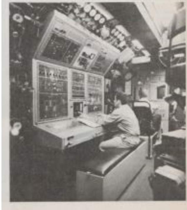
Faite control navigation et opération.
