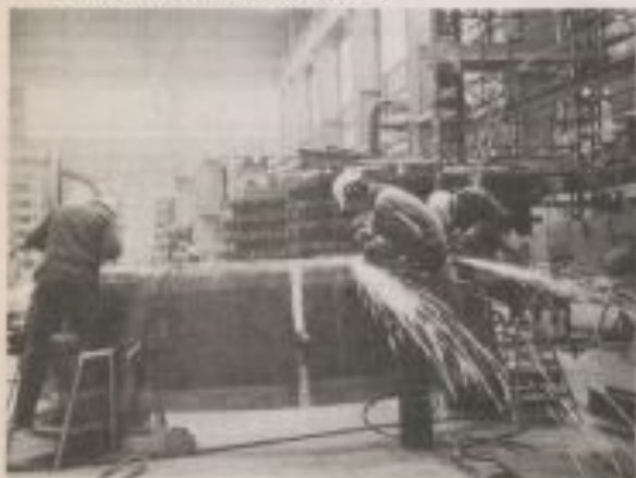
Préparation de la jonction de deux tronçons.
