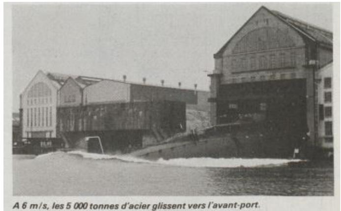
A 6 m/s, les 5 000 tonnes d'acier glissent vers l'avant-port.
