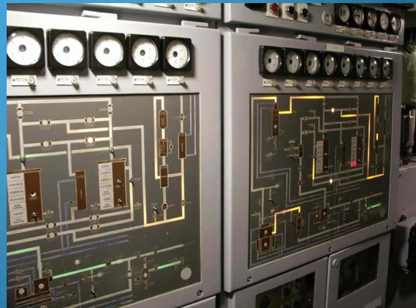
Usine à CO 2
