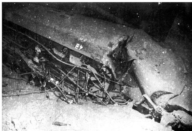
Epave du sous-marin EURYDICE. L'arrière qui sort du sédiment est coulé sur tribord d'environ 100 degrés. Au dessus des tuyaux et des câbles électriques se trouvaient les tubes lance-torpille arrière.( Archive auteur).
